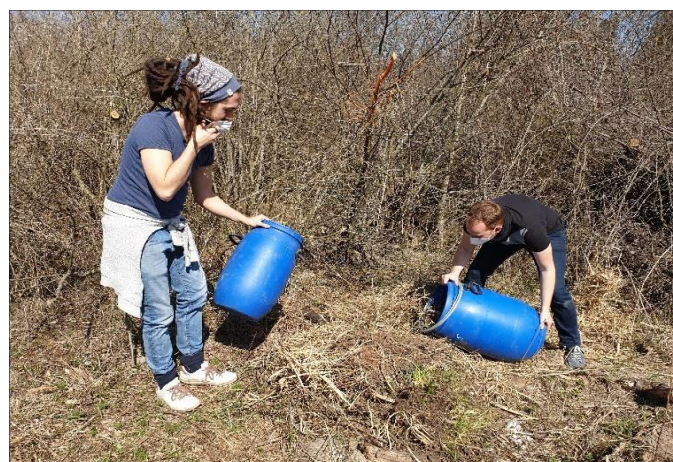
Umsiedlung beim Bau einer Fischtreppe am Lech
